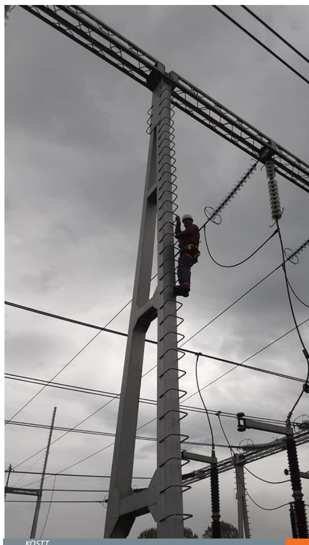
Pamje gjatë punimeve për largimin e materialeve të bartura nga shpendët në stabilimentet e tensionit 220 kV, fusha e largpërcuesve LP 205/1 dhe LP 267 në NS 400/220 kV Kosova
